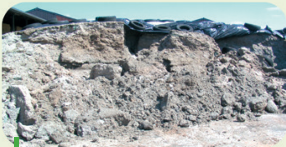
De vorming van vette pulp accentueert de instabiliteit van de silo en veroorzaakt instortingen
