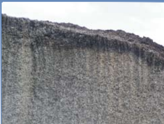
Figure 23 : Certains éleveurs utilisent une couche de radicelles pour terminer et fermer leur silo. Ils n'utilisent aucune bâche de fermeture. Cette technique semble être favorable à l'évacuation de la vapeur d'eau excédentaire, lors de l'ensilage de la pulpe. Ces silos, tassés avec soin, ne présentent aucun développement de moisissures ( Notice 26 ).
