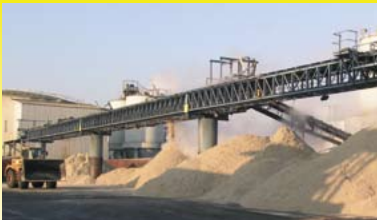
Figure 4 : L'évacuation de la pulpe s'effectue à l'usine selon la technique «first in / first out» où différents tas de pulpe sont successivement réalisés et évacués ( Notice 8 ).
